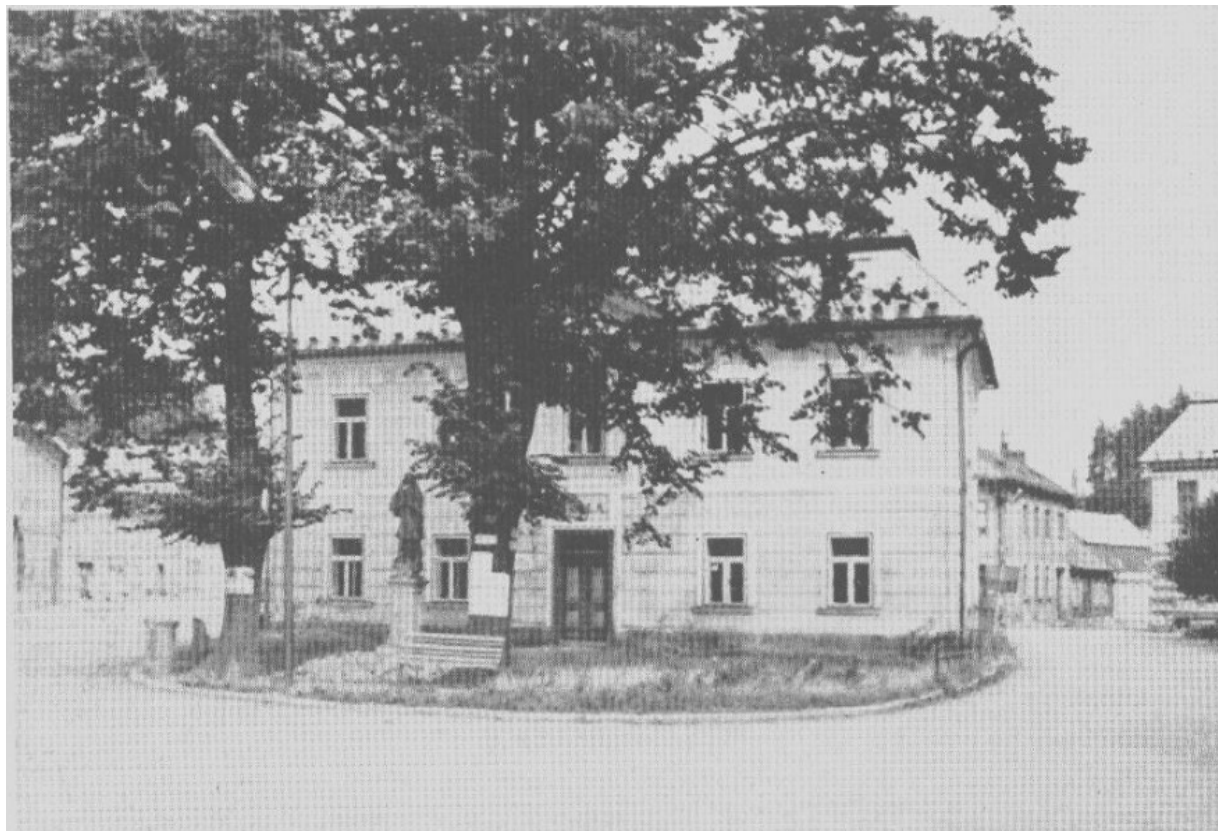
Obr. 1: Budova „Horní školy“ v Jimramově, před budovou socha sv. Jana Nepomuckého
